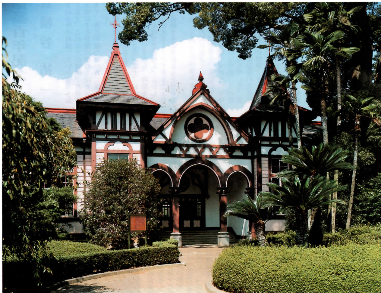
竣工当時の色で蘇った旧本館
