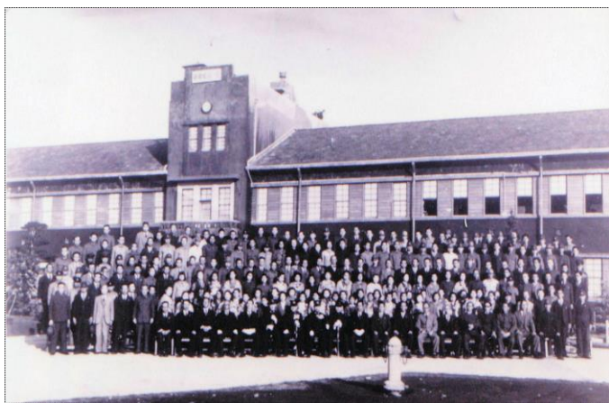
昭和17年当時の第一海軍航空廠庁舎と職員。庁舎は、現在の陸上自衛隊霞ヶ浦駐屯地・関東補給処の地にあった。
