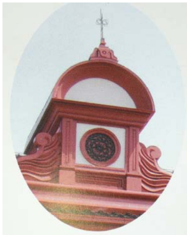
2階屋根中央のゲープル
