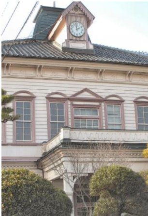
津山中学校(現岡山県立津山高等学校)
