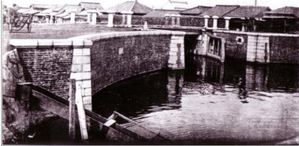
霞ヶ浦側から見た川口川開門(1907年) 開かれている鉄扉が遺構となっている
